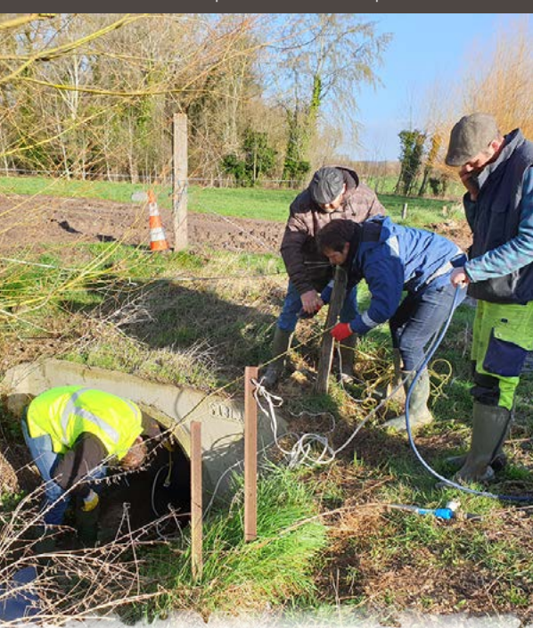
Mise en place de la baudruche pour obturer la buse
